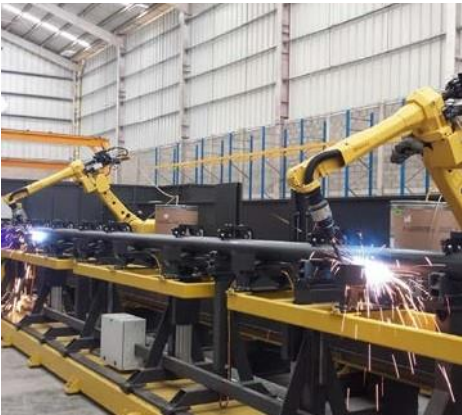
Soudage de tubes métalliques Positionneurs avec 2 robots
