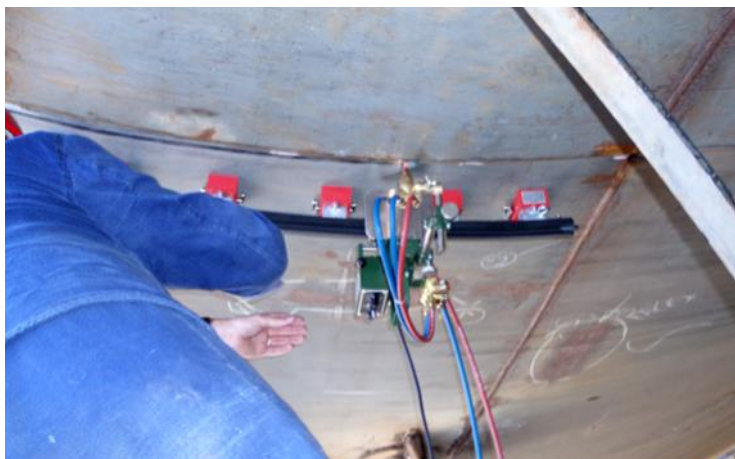
Coupe aérienne rendue possible grâce aux aimants permanents solides
