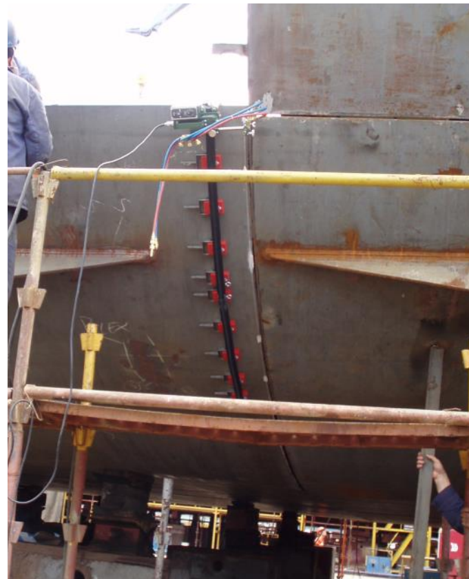
Préparation de la soudure effectuée avec le rail 2D
